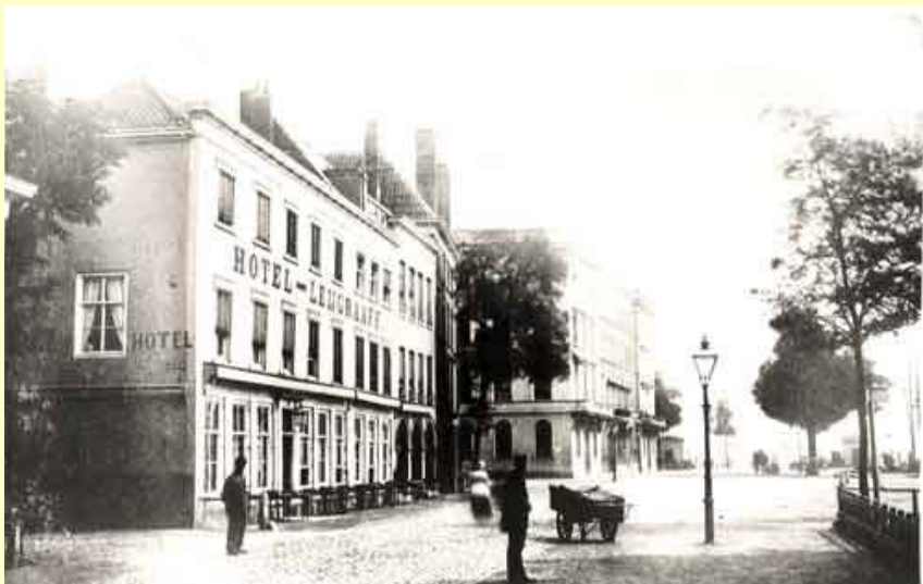
Hotel Leygraaff aan het Westplein in Rotterdam was al in 1878 in het bezit van een eigen elektrische installatie. Bron: Gemeentearchief Rotterdam.
