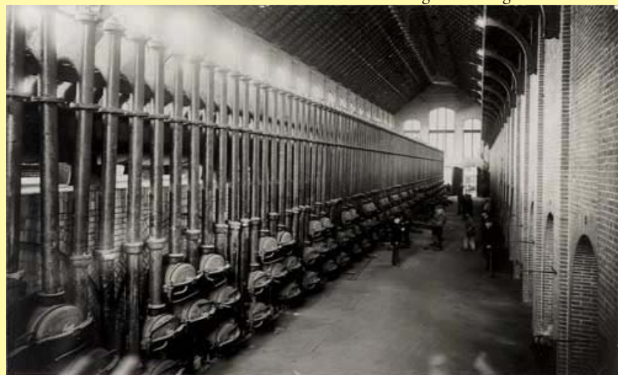
Door steenkool in ovens (retorten) te verhitten ontstaan steenkoolgas en cokes. Op de foto het retortenbuis van de Gemeente Gasfabriek Oostzeedijk in 1887.
